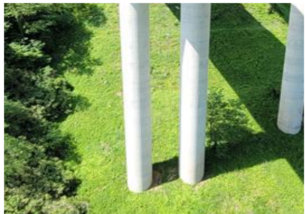
교각 P2 기초 전경
