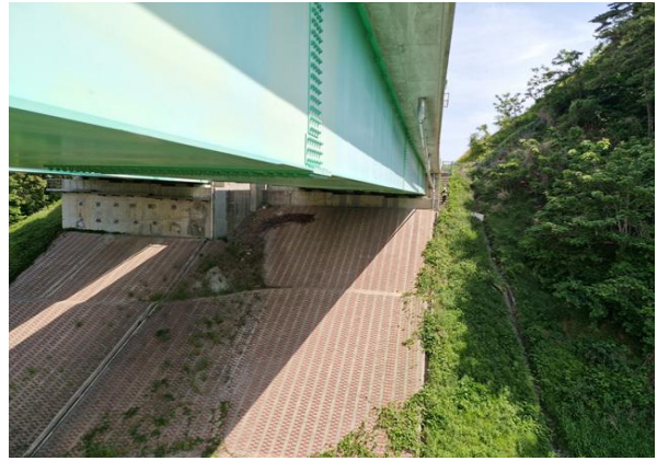
교대 A2 기초 전경
