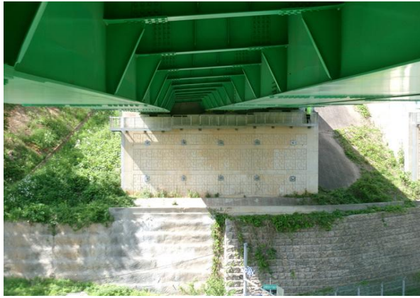
교대 A1 기초 전경
