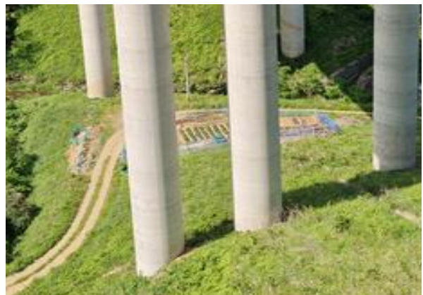
교각 P4 기초 전경
