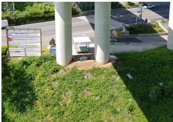
교각 P1 기초 전경
