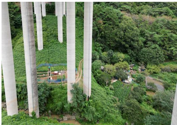
교각 P3 기초 전경
